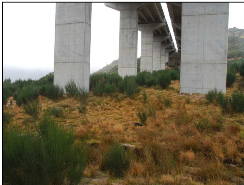
Figura 4.11 – Aspecto do ponto V1.
