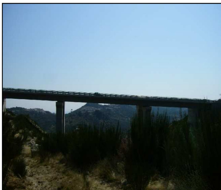
Figura AII.6 – Ponto P6, Viaduto 4.
