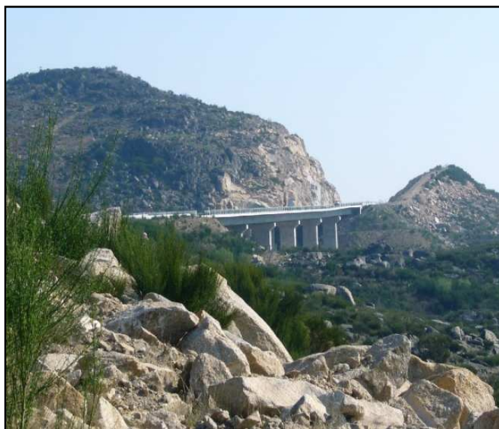
Figura AII.7 – Ponto P7, Viaduto 5.
