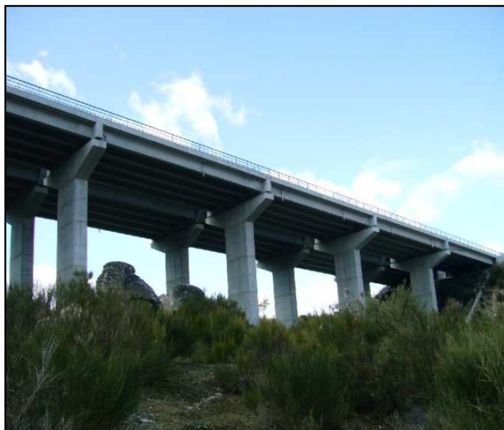
Figura AII.1 – Ponto P1, Viaduto 1.
